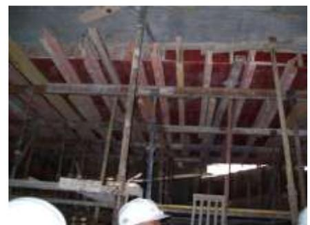
Fig. 12 : After Shuttering fabrication
